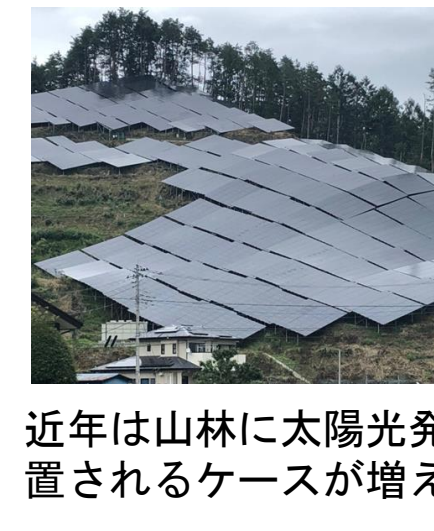
近年は山林に太陽光発電が設置されるケースが増えている
